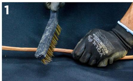
1 Para a remoção da camada de óxido dos condutores, faça uma escovação utilizando uma escova com cerdas de aço ou latão.
